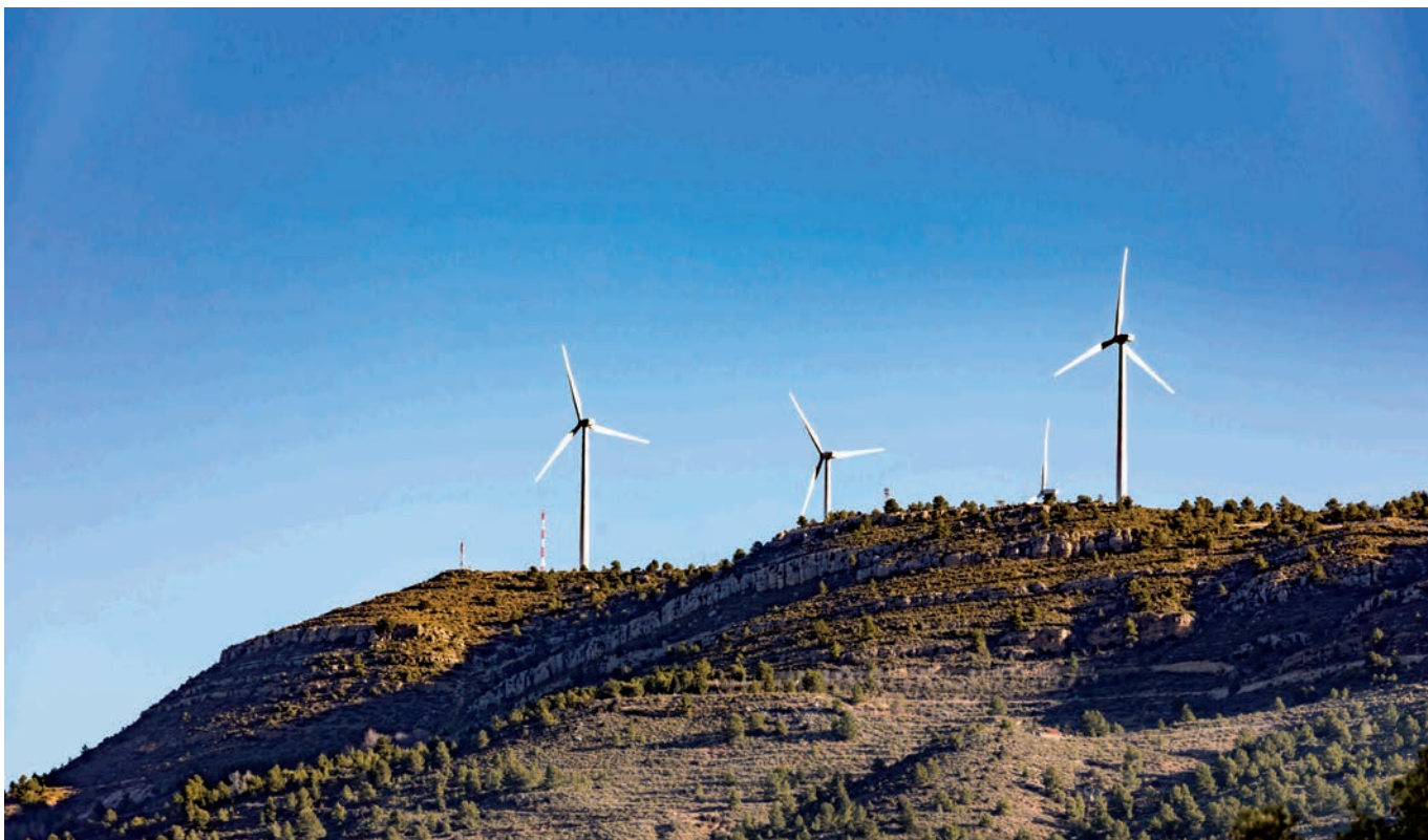
Aerogeneradores en Aras de los Olmos.
