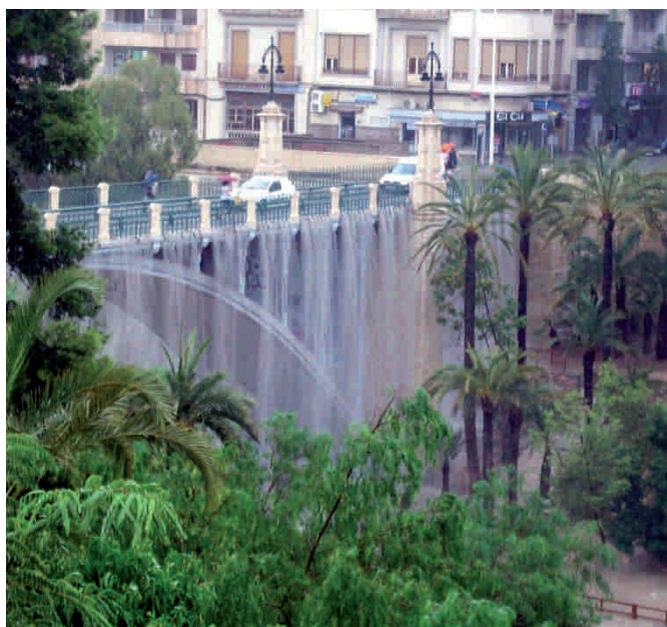
Inundación en el puente Canalejas. Elx (Alicante) 2009.
