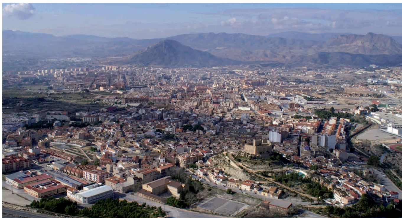
Conurbanización en el eje del Vinalopó.
